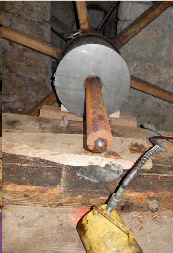
Rechts: Das Wunder ist gelungen, der stark angerostete Wellenstumpf konnte geborgen werden. Damit war der Weg frei für den zweiten und ebenso heiklen Schritt, die Bohrung des Lochs für die neue, dickere Stahlwelle (Foto R. Waldmeier).
