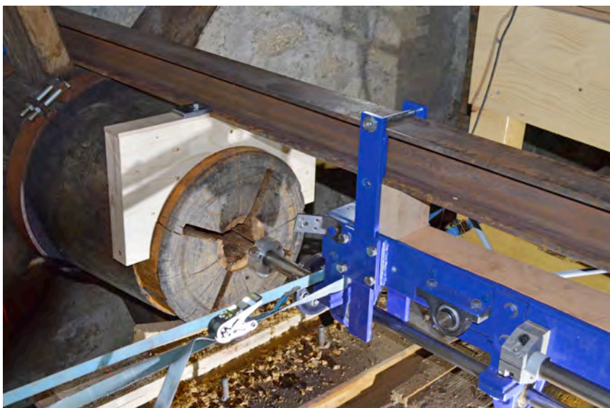
Das Loch für die neue Stahlwelle wird gebohrt. Dafür wurde ein spezieller Bohrkopf konstruiert. Um die nötige Präzision der Bohrung zu ermöglichen, musste der Bohrer fest an eine Eisenschiene montiert werden (Foto R. Waldmeier).
