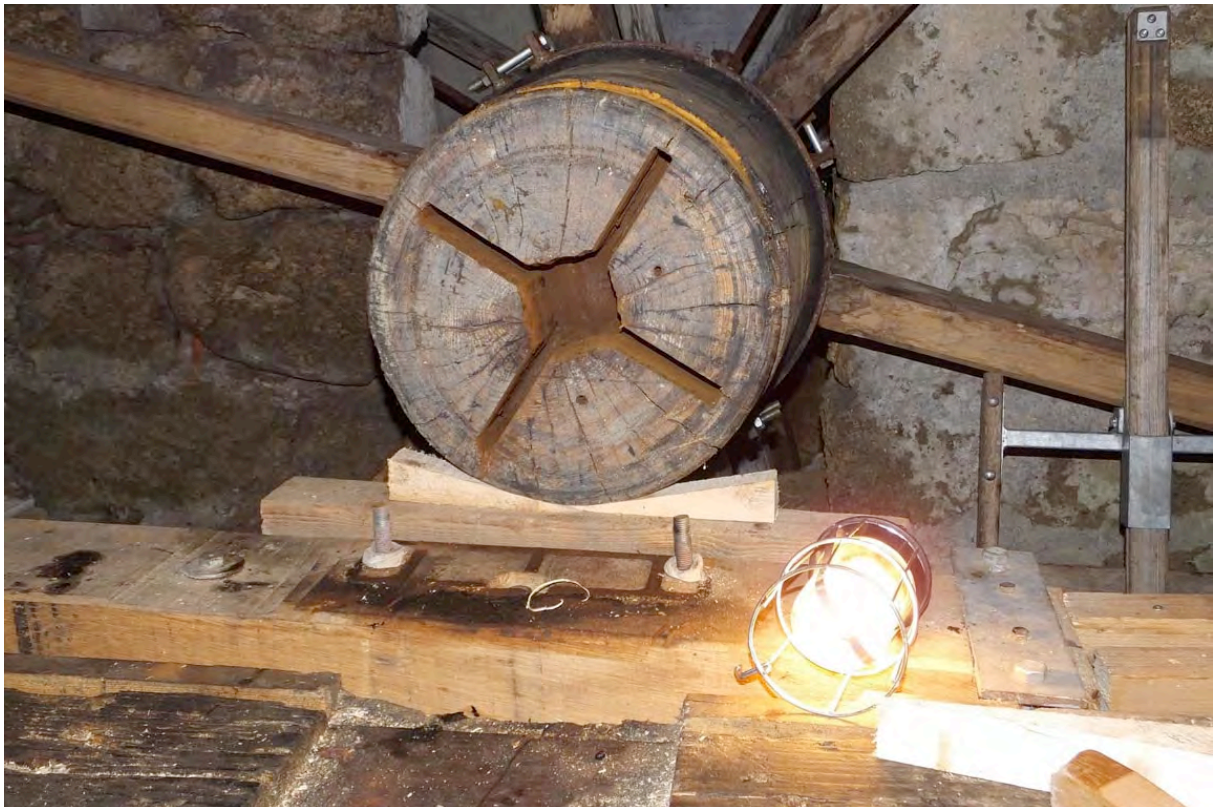
Nachdem das Ende der gebrochenen Welle herausgezogen war, wurde die rostige Bruchfläche erkennbar (Foto U. Weber).
