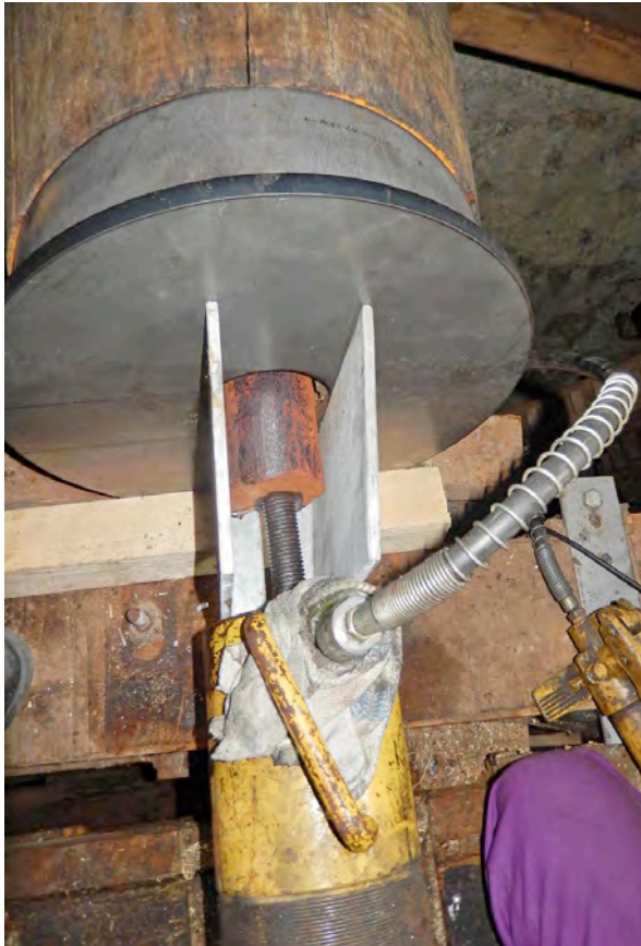
Links: Mit Hochdruck und einer eingebohrten Gewindestange wird der Wellenstumpf ruckweise aus dem Holzkörper gezogen. Um die Holzwelle vor den grossen Kräften zu schützen, wurde eine spezielle Stahlkappe hergestellt und auf den Kopf der Holzwelle gesetzt (Foto R. Waldmeier).
